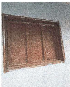
Foto 3: Sustrucción de ventana de madera por metal mas vidrio aula 2, y fabricaci3n e instalaci3n de balcon de metal
