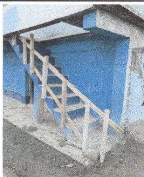
Foto 7: Sustitución de barandas por metal módulo 1
