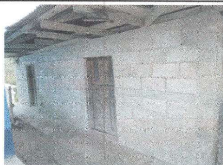
Foto 12: Repello en muro
