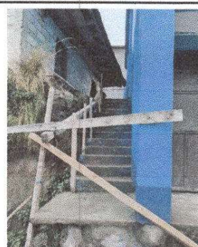
Foto 8: Sustitución de barandas por metal módulo 2
