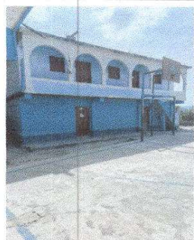
Foto 10: Pintura en muros exteriores e interiores
