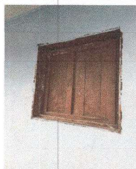
Foto 4: Sustrucción de ventana de madera por metal mas vidrio aula 1 y fabricaci3n e instalaci3n de balcon de metal
